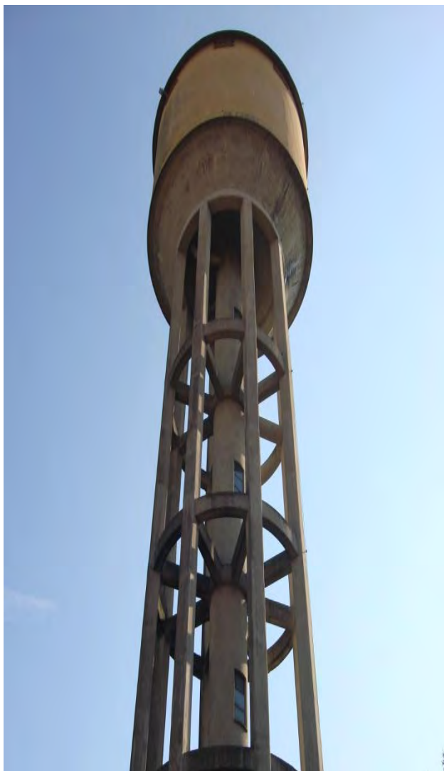
Torre piezometrica – Vicolo Crocifisso
